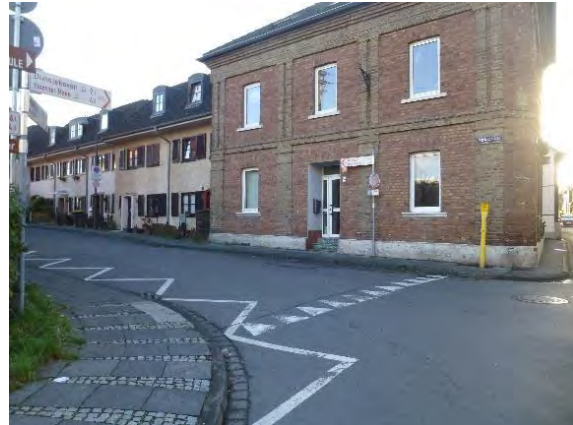
Abbildung 12: Schmalere Gehweg im Kreuzungsbereich
