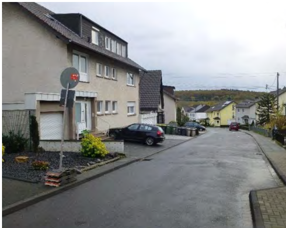
Abbildung 9: Fehlende bzw. zu schmale straßenbegleitende Gehwege
