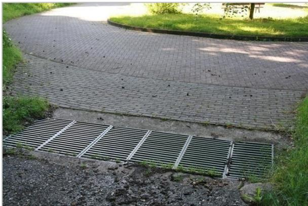
Abbildung 9.5: Vorhandene Linienentwässerung oberhalb des Wendehammers am Nachtigallenweg
