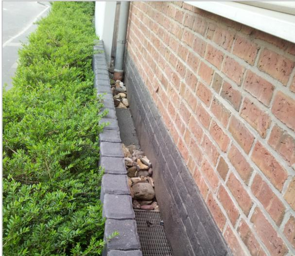
Abbildung 12.22: Objektschutz im unteren Bereich des Stühleshofs – Palisaden mit dazwischen angebrachter Silikondichtung
