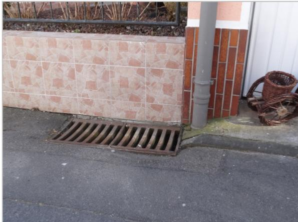
Abbildung 12.10: Beispiel für einen gut dimensionierten, doppelt ausgeführten Regeneinlauf in Alfter
