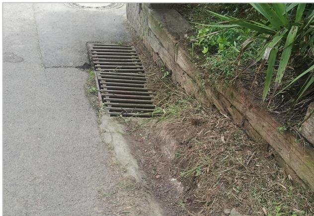
Abbildung 12.4: Einlauf in die Bachverrohrung
