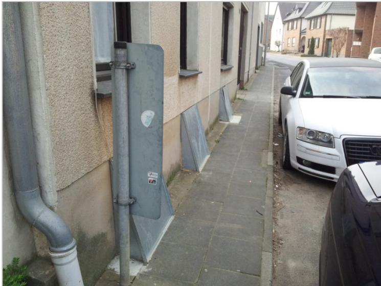
Abbildung 12.21: Objektschutz im unteren Bereich des Stühleshofs – Lichtschächte verschlossen
