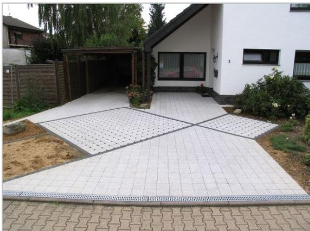
Abbildung 12.16: Hofffläche mit Gefälle zur Straße und Entwässerungsrinne
