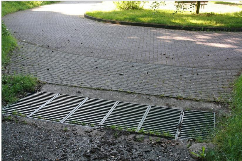
Abbildung 12.5: Linienentwässerung oberhalb des Wendehammers am Nachtigallenweg
