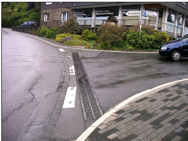
Abbildung 8.31: Beispiel für eine Linientwässerung zur Ableitung des Straßenabflusses
