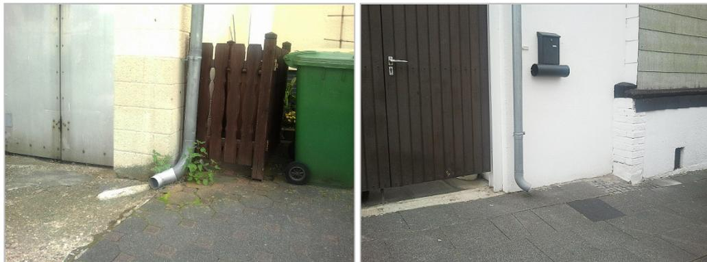
Abbildung 12.14: Direkte Ableitung von Dachwasser auf die Straße (Beispiele aus Alfter)
