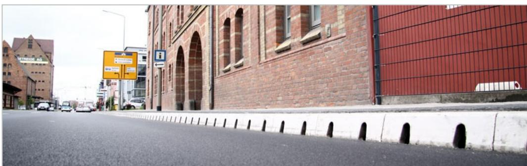
Abbildung 12.13: Monolithische Bordsteinentwässerung
