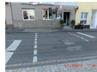
So sollte es sein: Abgesenkter Bordstein beim Eissalon
